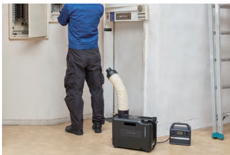
建物の設備メンテナンス
