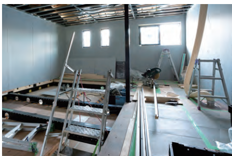
工事・建設現場
